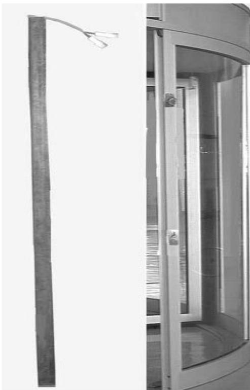
Desmonte el adaptador del disyuntor de seguridad C07, C08 con aguja, pase los cables por el orificio de la cubierta, vuelva a conectar los adaptadores y, a continuación, enchufe en el adaptador C07, C08
